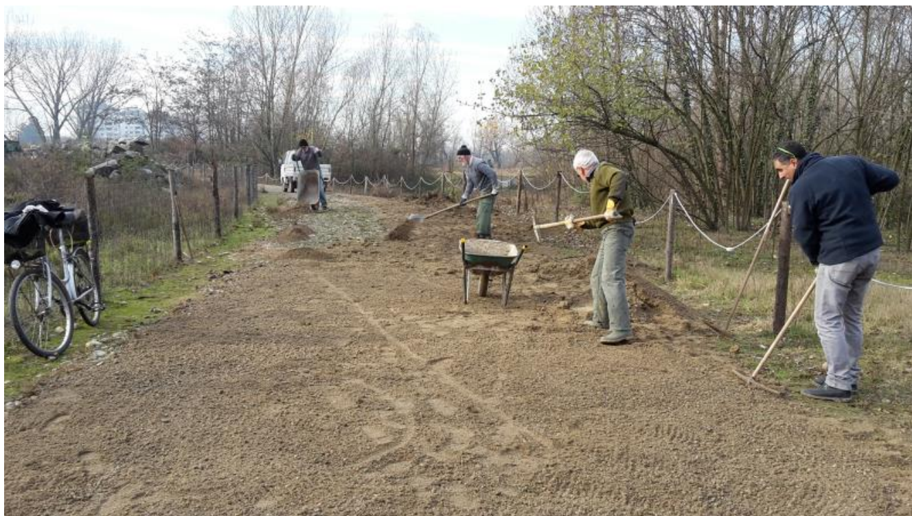
Volontari al lavoro nella manutenzione del percorso pedonale
